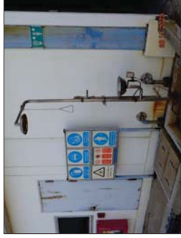
รูปที่ 17 อ่างล้างตา และฝักบัวล้างตัวในพื้นที่โครงการ
